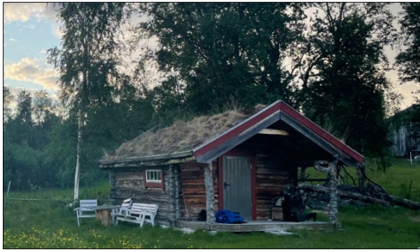
Figur 17: Hytte 3 står tett ved beboernes private parkeringsplass vest for gardstunet. Plasseringen er ugunstig (Foto: G. Ryen, Feste Nordøst as).
