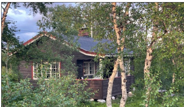
Figur 15: Hytte 1 ligger ved Hyttbekken, lett tilgjengelig fra veien inn til tunet. Grunnforholdene er dårlige og det er behov for å flytte hytta til bedre grunn. (Foto: G. Ryen, Feste Nordøst as)
